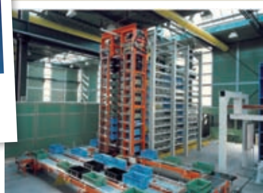
1989 "SISTORE" - Hochleistungs- behälterregallager
